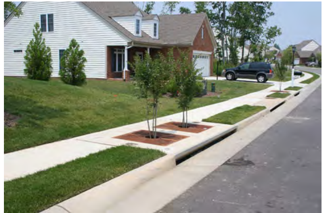
Example of Filterras.
